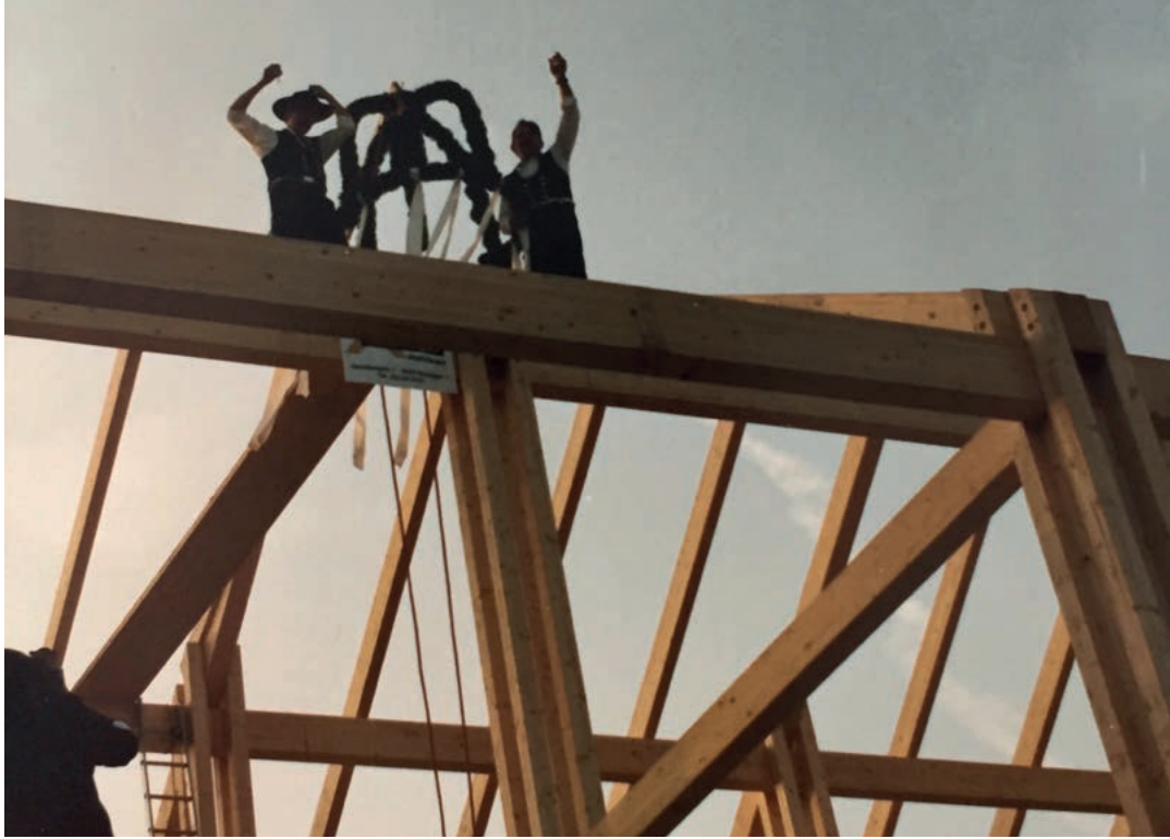
Wenn der Dachstuhl steht, wird Richtfest gefeiert.
