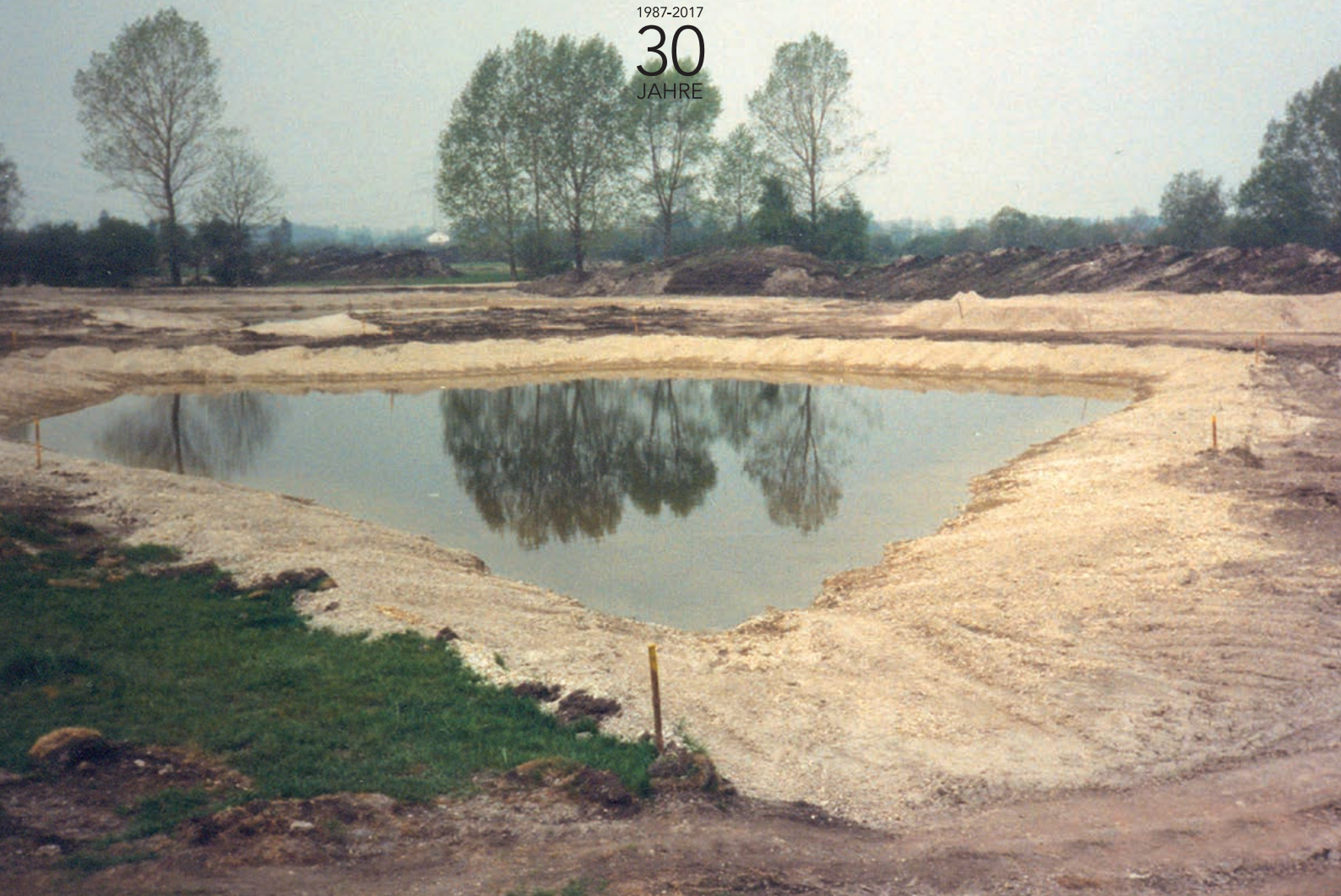
19. März 1988: Erster Spatenstich für die Golfanlage mit 80 ha Fläche auf dem Gut der Familie Weiler am Ortsanfang von Eichenried, Gemeinde Moosinning; 17. Juni 1989 Platzeröffnung des 18-Loch-Meisterschaftsplatzes, gebaut von Golfplatzarchitekt Kurt Roßknecht.
